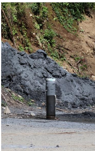
地下水試験の箇所 (2022.9.6)
